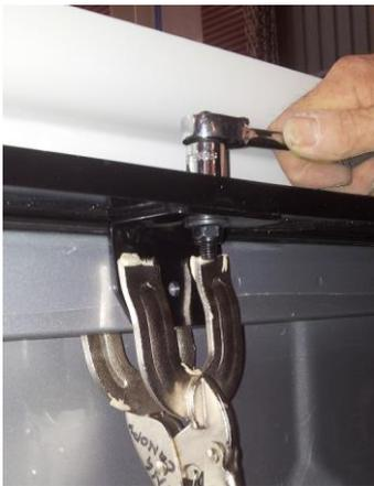
4.3 Suchen Sie die in der Mitte des Schienenträgers befindlichen Schlitz (2 Stück). Klammern Sie die Halterung (668PD056) an der Ladewandlippe fest. Stecken Sie eine M8x25mm Schraube mit M8x20mm Distanzscheibe durch die Halterung. Schrauben Sie von unten eine Nyloc-Mutter mit M8x20 Distanzscheibe dagegen und ziehen Sie alles mit einem Drehmoment von **22Nm fest. Führen Sie diesen Arbeitsschritt an beiden Seiten des Fahrzeugs durch.**
